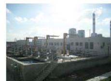
上海竹园第一污水处理厂
