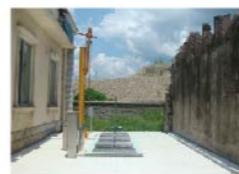
四川遂宁污水处理厂
