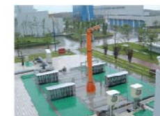
杭州七格污水处理厂
